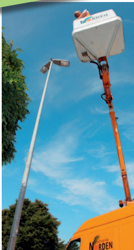
Hoch hinaus: Mithilfe eines Steigers erreichen die Stadtwerke-Mitarbeiter die Lampen.
